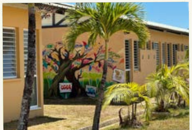
Exterior do edifício
